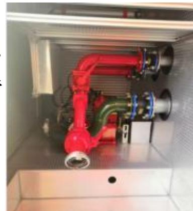
**注水口:** 泵房两侧左右各 2 个DN80(卡式雄口)注水口，并安装抗腐蚀性滤网，滤网孔径 13mm 带闷盖。
