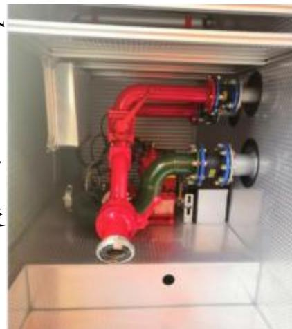
**放余水管路：**为保护水泵及各球阀，在管路的最低处加装放余水球阀。开关引出便于操作。
