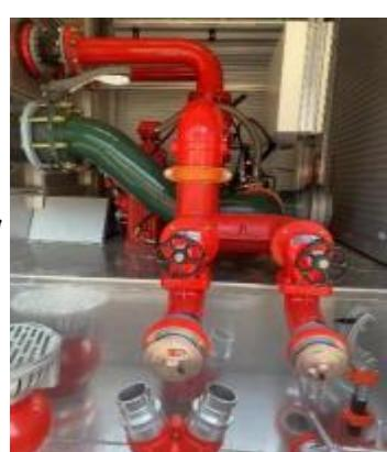
**注水口：**泵房两侧左右各2个DN80(卡式雄口)注水口，并安装抗腐蚀性滤网，滤网孔径13mm，带闷盖。
